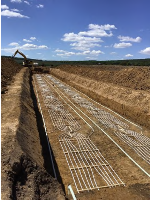
Abbildung 40: Verlegung von Erdwärmekollektoren, Nahwärmenetz Bad Nauheim Süd (Regionalverband FrankfurtRheinMain)
